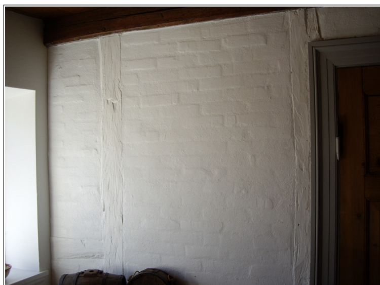
Illustration 6: Bindingsværksvæggene i køkkenet er istandsat og ført tilbage til tidligere udseende. I dag står de med en smuk silkemat overflade.
